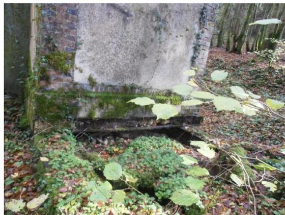
Il se compose d'un seul ouvrage profond de 12 m. L'ouvrage est ancien. Au dessus de la porte d'accès frontale, la date de 1912. Dans sa partie supérieure, l'ouvrage est en très mauvaise état permettant l'accès à de petits animaux (non étanchéité de la porte, de la base du bâtiment, fissures dans la maçonnerie).
